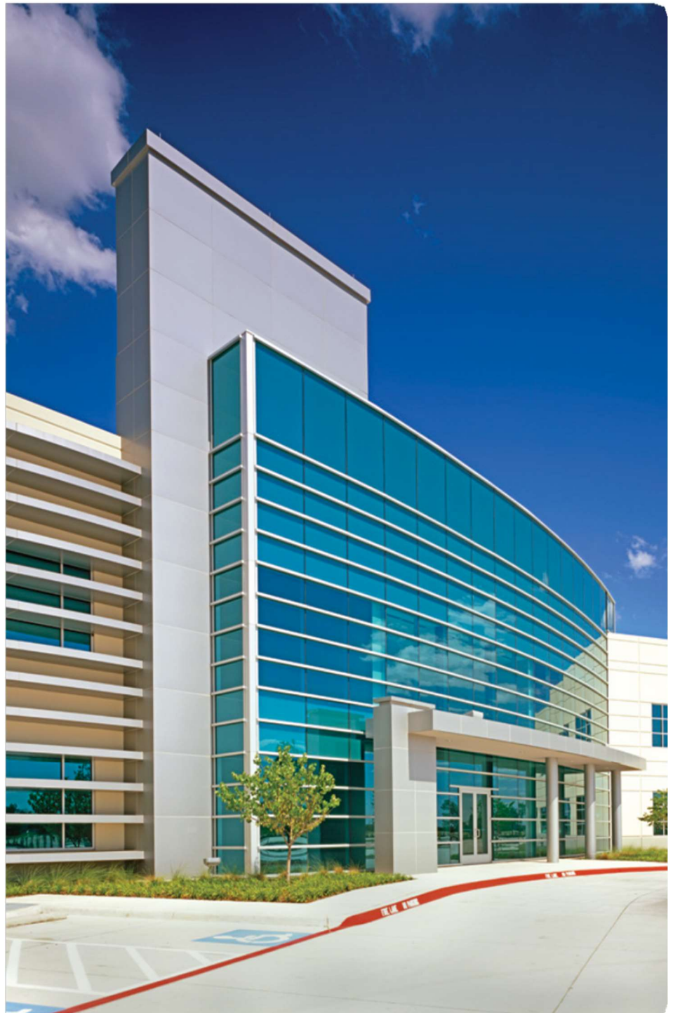
El vidrio Vistacool® Azuria®, que se ve aquí en el Centro Corporativo Transwestern Gateway I en Coppell, TX., Presenta un rico tinte azul tropical y una mejor transmisión de luz visible que los vidrios de color azul de manera similar.
